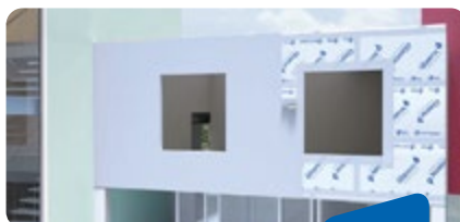
APLICACIÓN DE MORTERO PARA CAPA DE REGULARIZACIÓN
