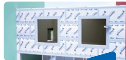
TRATAMIENTO DE JUNTAS CON PLACOTHERM® BASE
