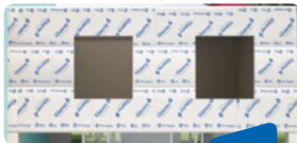
COLOCACIÓN PLACA EXTERIOR GLASROC® X / AQUAROC®
