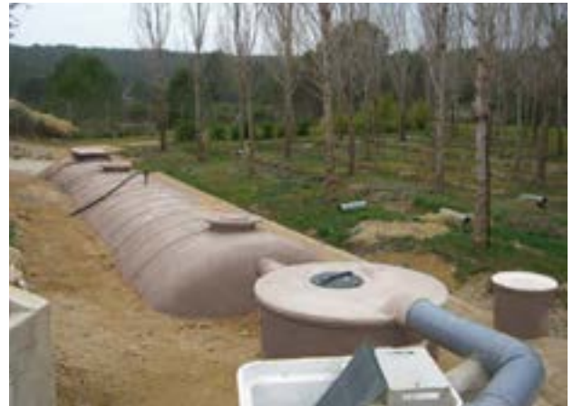
Instalación depuradora perfil hidráulico Instalação de depuradora de perfil hidráulico
